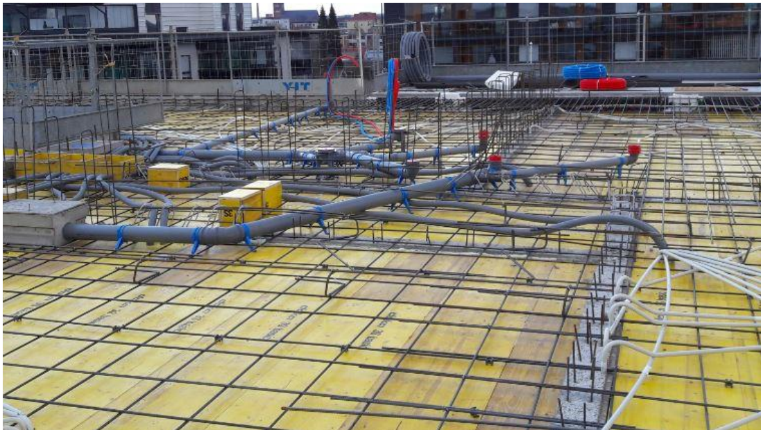
Kuva 15. Holvin raudoitusta sekä putkistoa
