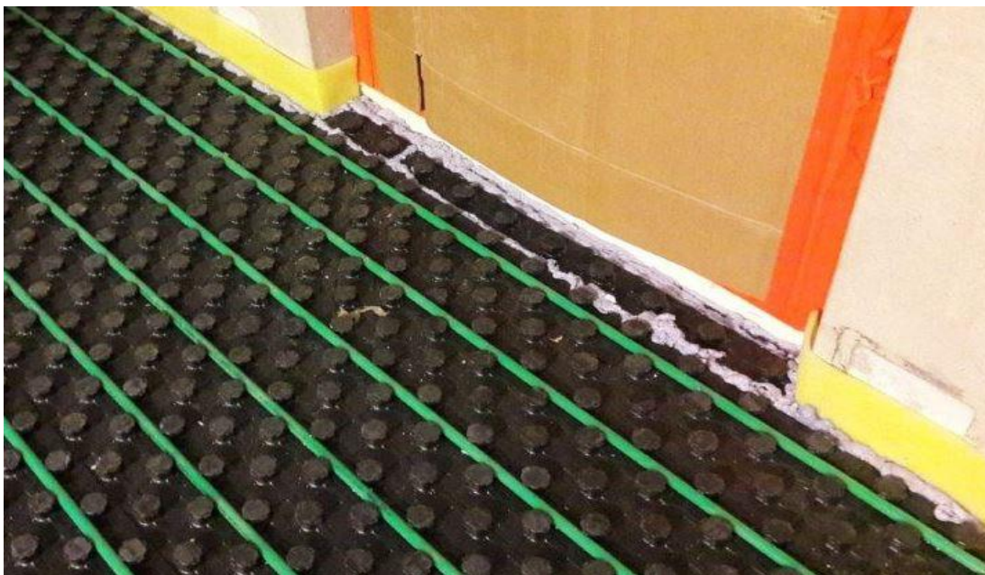
Kuva 7. Reunanauha sekä eristevaahto asennettuna (kuvannut Juha Oksa, 2017)
