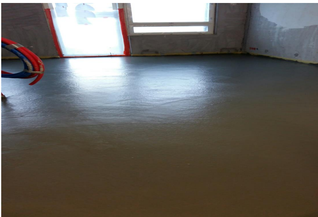
Kuva 12. Valettu ja tasoitettu pintalattia
