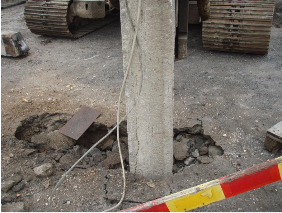
Kuva 10: Koepaalun 3 lyöntiä Piikkiössä.
