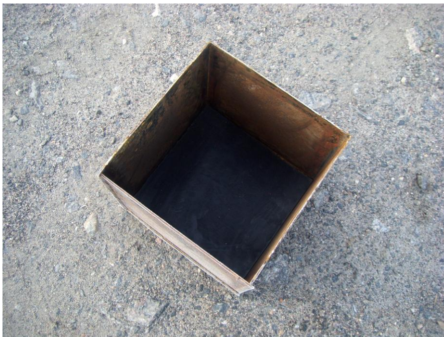
Kuva 16: Piikkiön koepaalutuksissa käytetty laatikkokärki.
