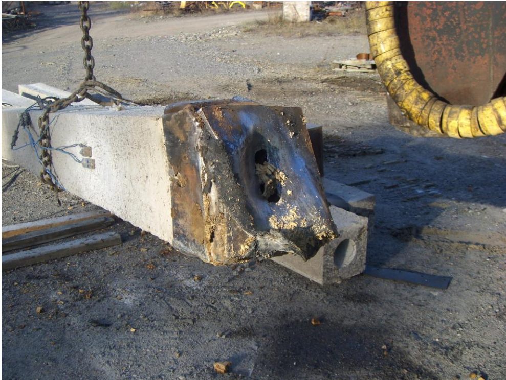
Kuva 17: Koepaalu 1 vaurioituminen yläpäätä.
