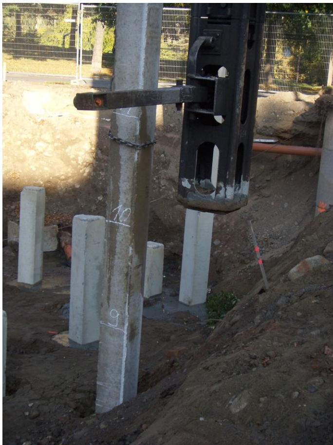
Kuva 8: Esijännitetyn paalun lyönti kirkon työmaalla. Taustalla tavallisia raudoitettuja betonipaaluja.
