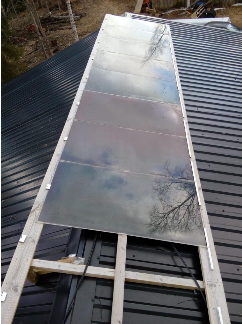
Kuva 1. Aurinkopaneelien asennus korjaamorakennuksen katolle puujalustalle.
