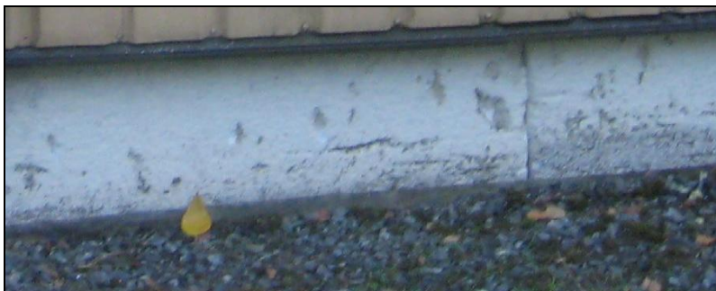
Kuvio 8: Rakennuksen päätyjen EPS-eriste
