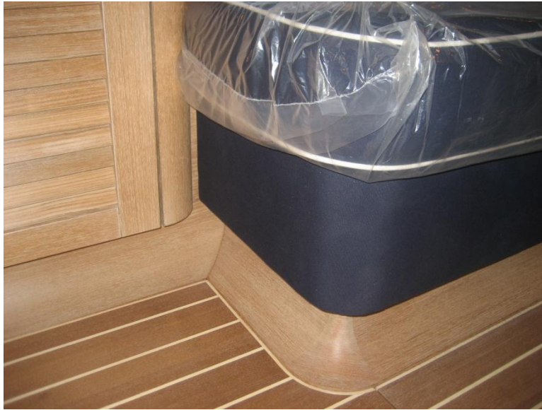
KUVA 30. S90-706:n sokkeli, kuvassa kulmakappale paikallaan
