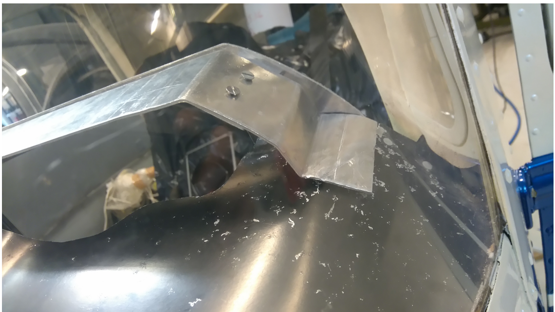
KUVA 38. Korvakkeen asennus pilotin penkin puolelta.
