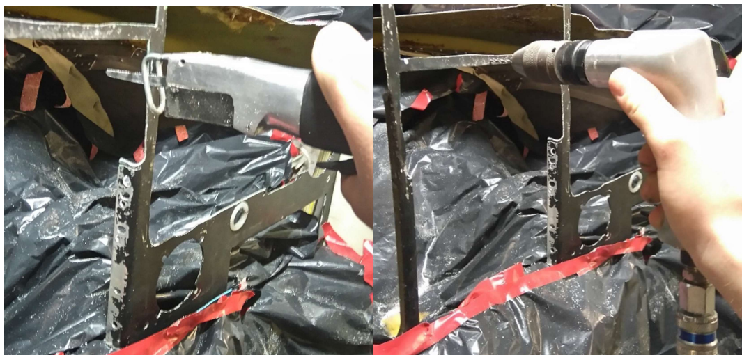
KUVA 21. Rakenteen leikkausta ja porausta.
