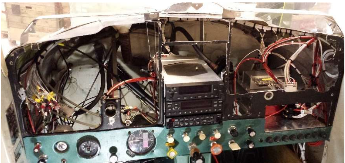
KUVA 77. Lopullisen asennus alkuvaiheessa.
