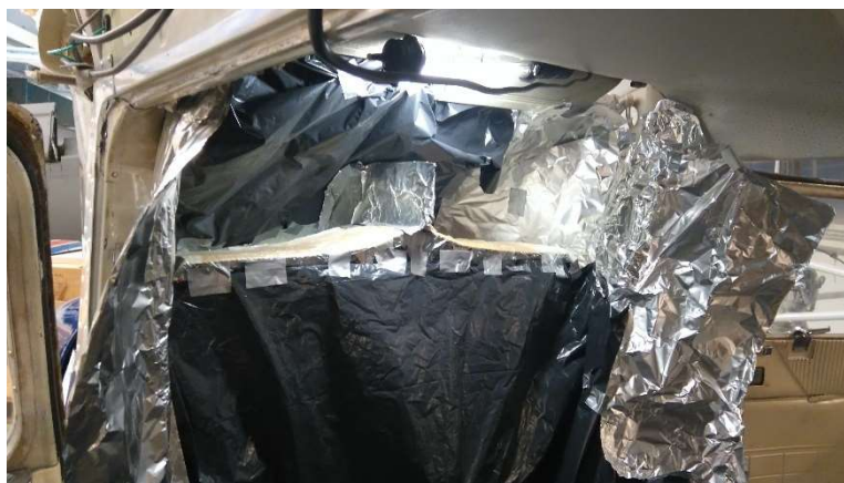
KUVA 45. Ohjaamon valmisteleminen uretaanivalua varten.
