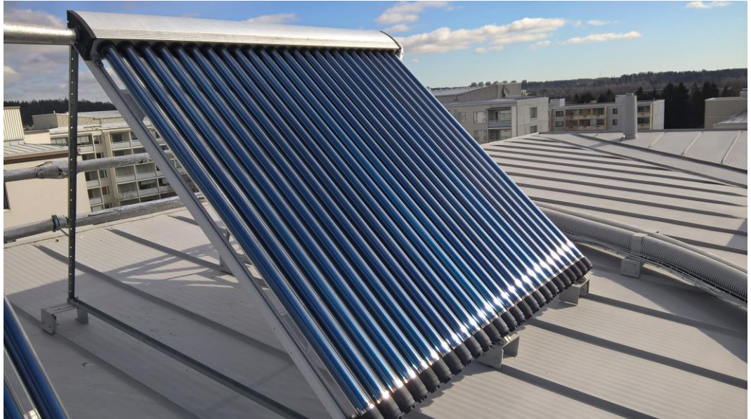
KUVA 5. Alumiiniprofiileilla on luotu haluttu asennuskulma aurinkokeräimille
