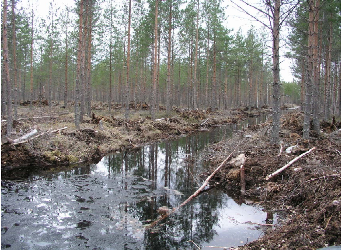
KUVIO 5. Putkipadon padotusta ojitusalueella. Keväällä vettä varastoituu tilapäisesti yläpuolisiin ojiin. (Kuva: Juha Jämsén.)
