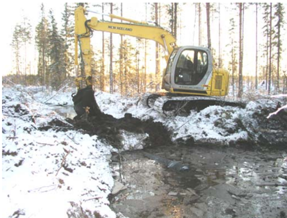
KUVIO 7. Putkipadon rakentaminen metsäojoaan. Kuva on otettu padon yläpuolelta. (Kuva: Juha Jämsén.)
