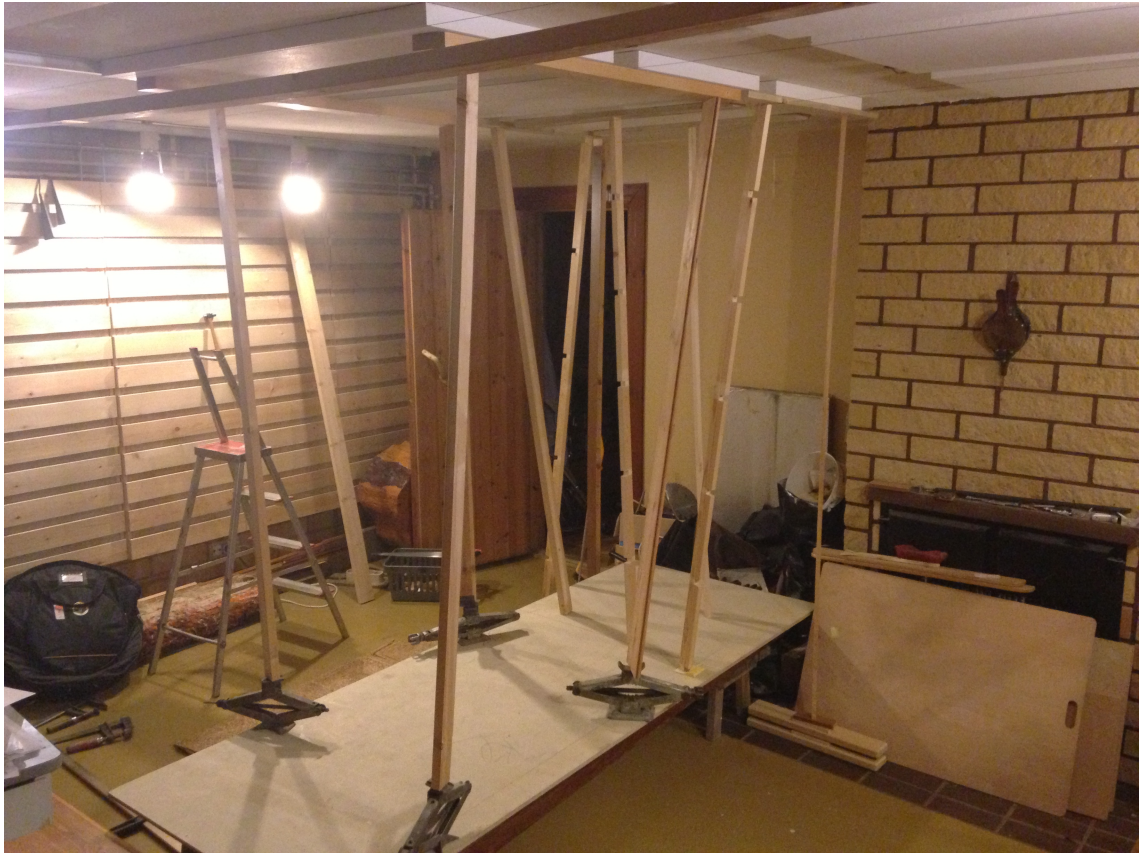
Kuva 4. Katon akustointilevyjen liimaamiseen tarvittiin tukea.
