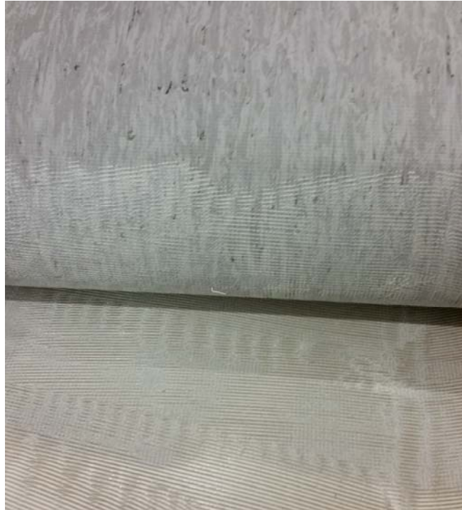
Kuva 5. Matto asennettiin pintaan myöhäisenä märkäliimauksena mattovalmistajan ohjeiden mukaan.
