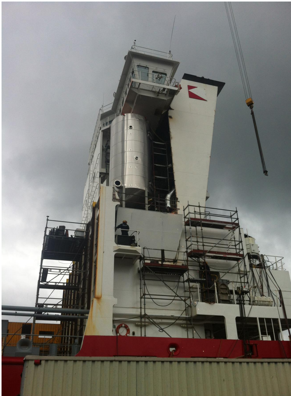
Kuva 11. Pakokaasupesurin pesutornin asennus M/S Ailalle 2014.
