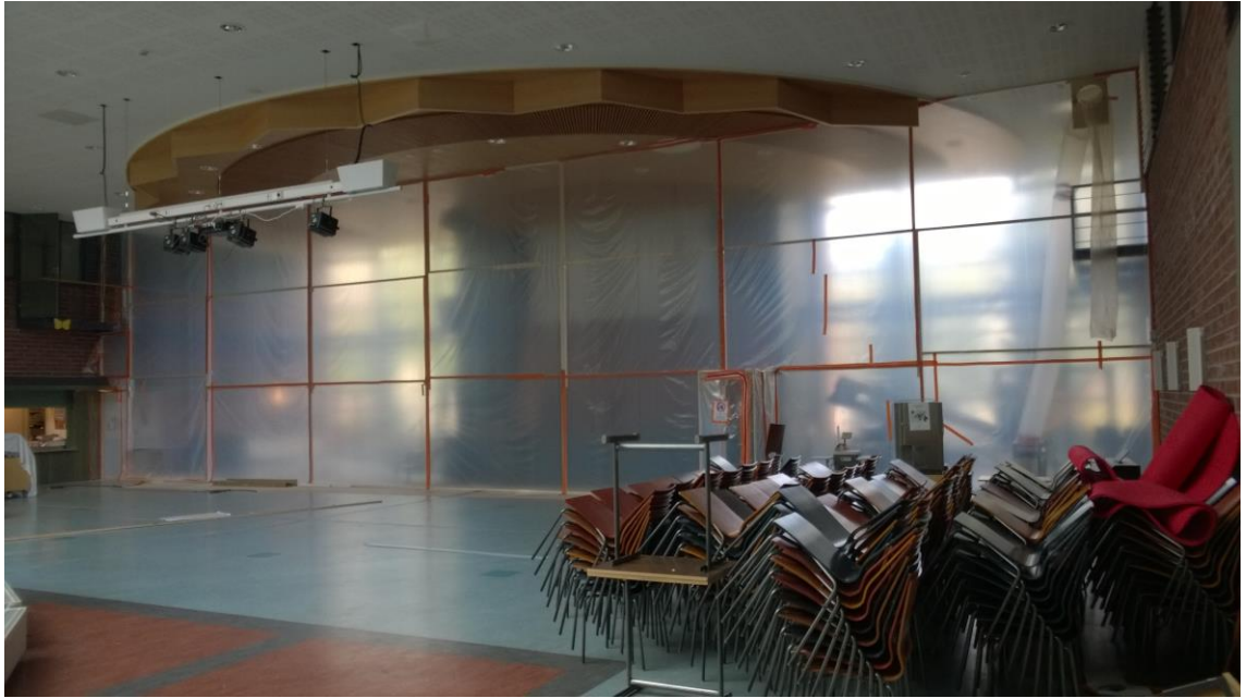
KUVA 6. Suuri tila, jossa osastoitu koko ulkoseinän mitta yhdellä kerralla
