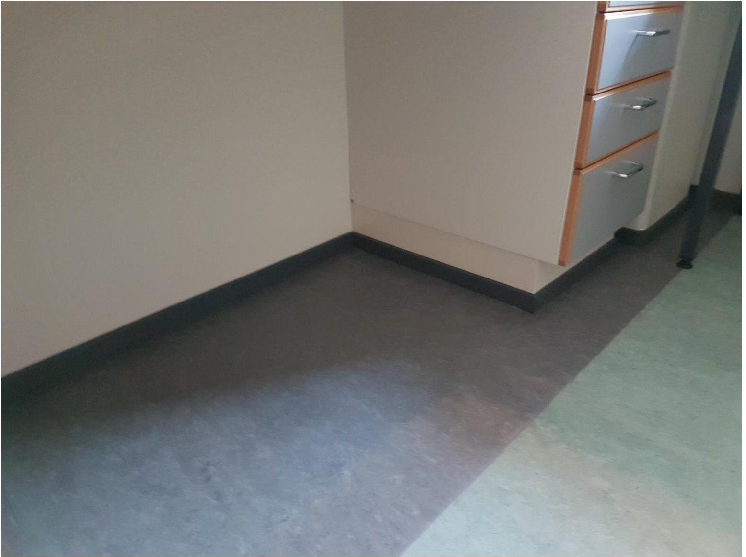
KUVA 10. Esimerkkitoteutus lattia-rajantiivistyksestä ja linoleum maton asennuksesta entisen lattiapinnan tasoon.
