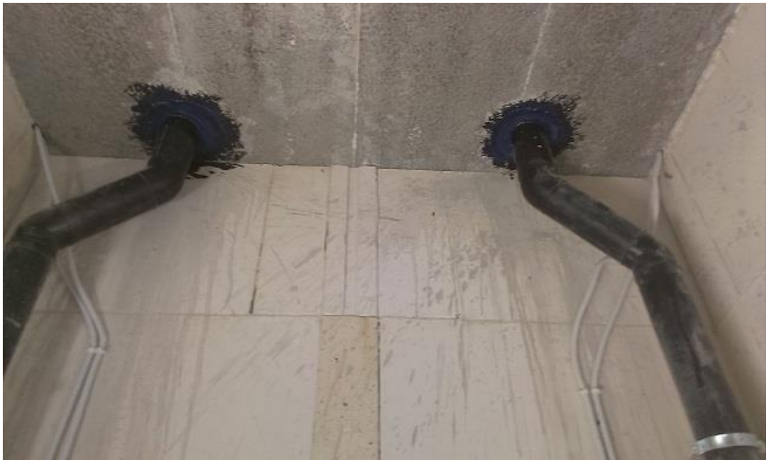
KUVA 7. Nestemäisellä vedeneristeellä tiivistettyjä läpivientejä
