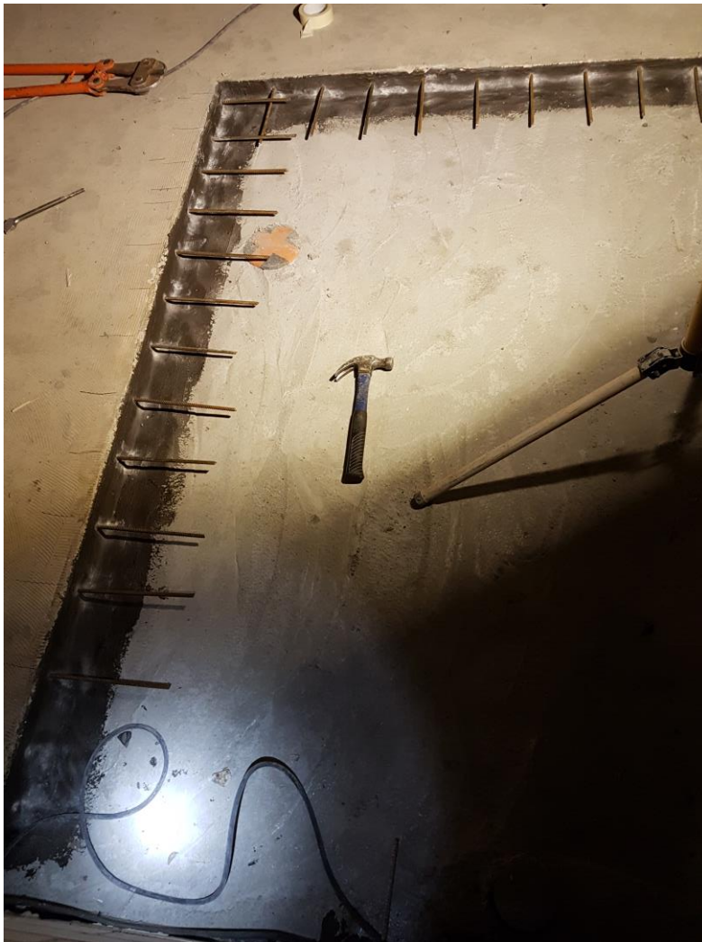
KUVA 8. Laattasaumat tiivistetty vedeneristyslaastilla ennen pintalaatan valamista
