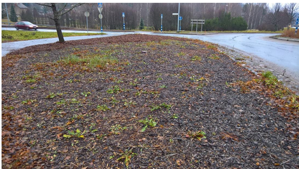
Kuva 6. Kuva syksyltä 2016. Erotuskaistan istutukset on poistettu näkemän parantamiseksi. Tilalle on levitetty kuorikatetta, joka kasvaa runsaasti rikkaa. (Joutsenniemi 2017.)
