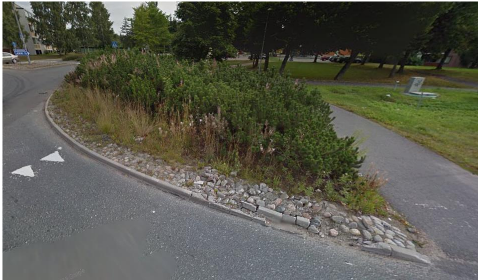
Kuva 5. Kuva vuodelta 2011. Erotuskaistan istutus on päässyt heinittymään ja pensaat kasvaneet liian korkeiksi hoidon puutteessa. Näkemä istutuksen takana olevalle suojatielle on kiertoliittymään tultaessa erittäin huono. (Google 2017b.)
