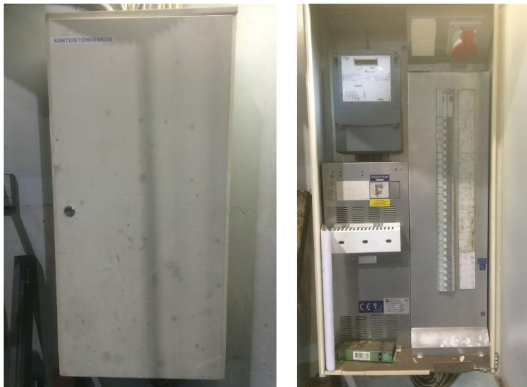
KUVA 16. Kiinteistökeskus kk kuvattuna kansi kiinni ja kansi auki kosketussuojat vielä kiinnitettyinä (Niko Putkonen, 2017.)
