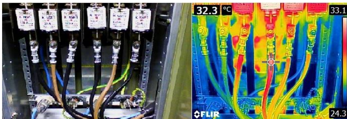
KUVA 6. Lämpokuva, josta ilmenee yhden pisteen lämpötila sekä kohteen pintalämpötilajakauma (Niko Putkonen, 2017.)
