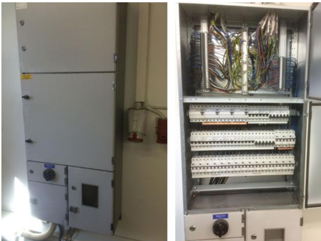
KUVA 20. RK9 kuvattuna kannet kiinni ja kannet aukaistuna suojakosketukset pois otettuna (Niko Putkonen, 2017.)
