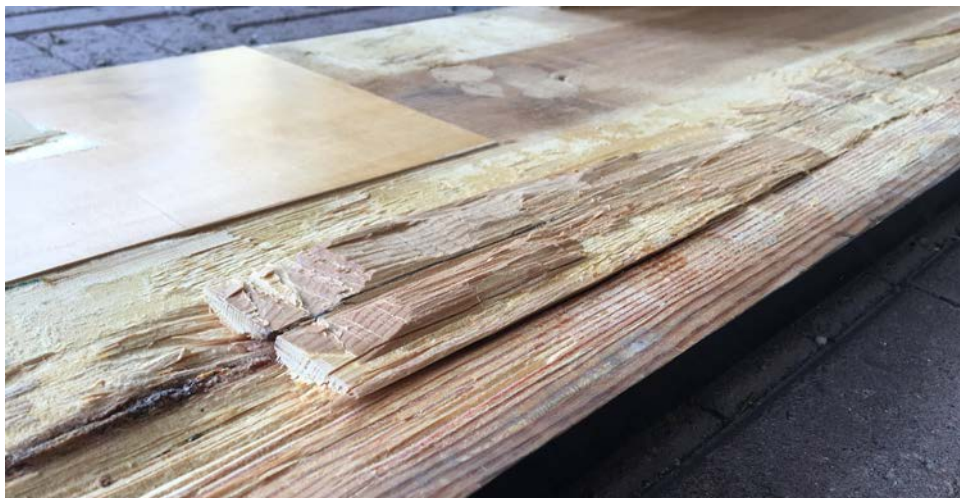
Kuva 22. Repeytynyt sivupaneeli
