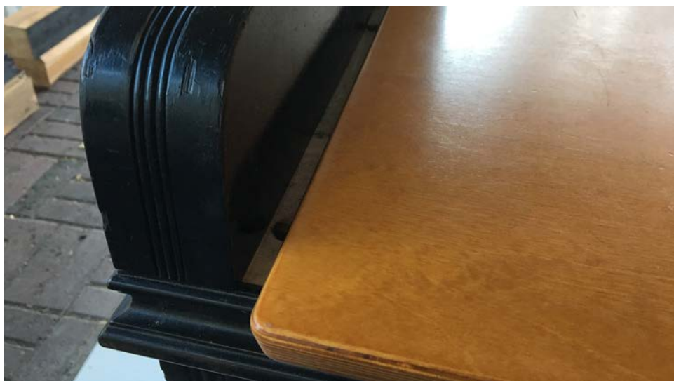
Kuva 34. Uusi pöytälevy on liian kapea
