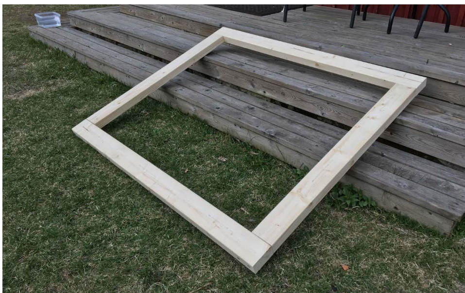
Kuva 29. Uusi tukirakenne koottuna
