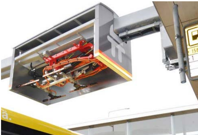
Kuva 2. Turun lentokentän laturi: ylhäältä alaspäin laskeutuva virroitinratkaisu (Turkulainen 2016).
