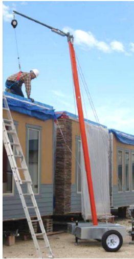
Kuvio 24 Yhdellä kiinnityspisteellä varustettu kiinnittäytymisteline (Free-Standing Single Point Anchor n.d.)
