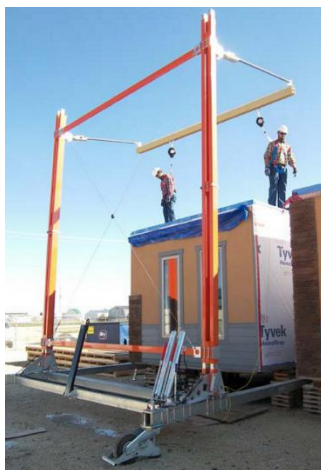
Kuvio 23 Kahdella kiinnityspisteellä oleva kiinnittäytymisteline (Free-Standing Horizontal Rail System n.d.)
