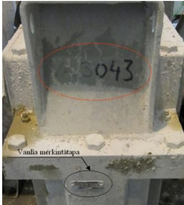
Kuva 13. Puutteelliset laitemerkinnät
