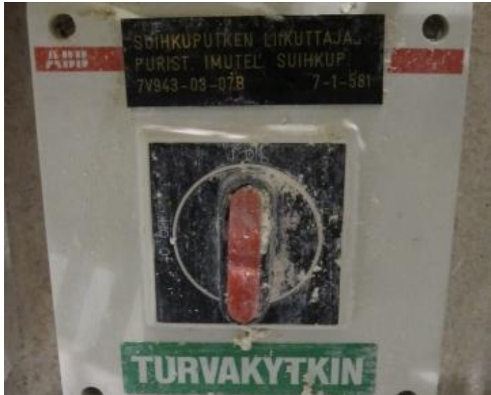
Kuva 11. Laitteen turvakytkimen merkintä
