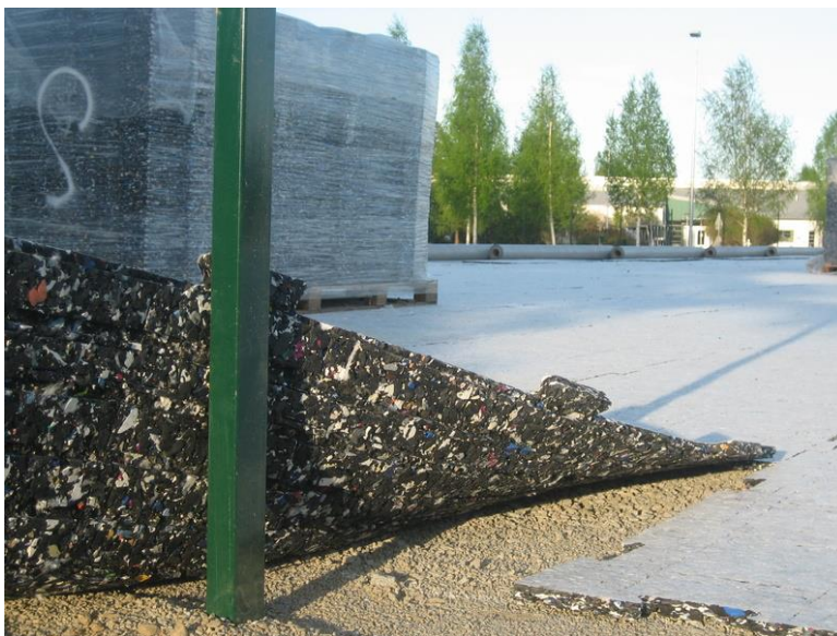
KUVA 11. Joustokerros asennuksen aikana (Kiuruveden palloilijat Ry)
