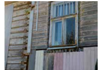
Rakennus kesken laajamittaisen kunnostuksen 2017
