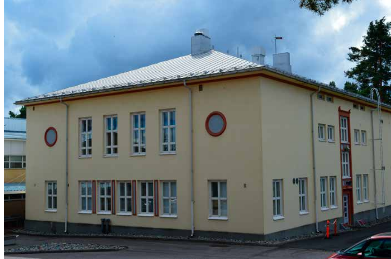
Yhteiskoulun vuonna 1929 rakennettu osa.
