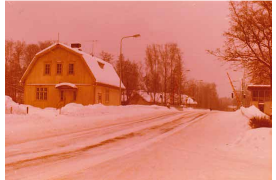
Kanavamiesten talo ja uusi kanavanvartijan koppi 1974/1975. Kuva: Matti Eskola.
