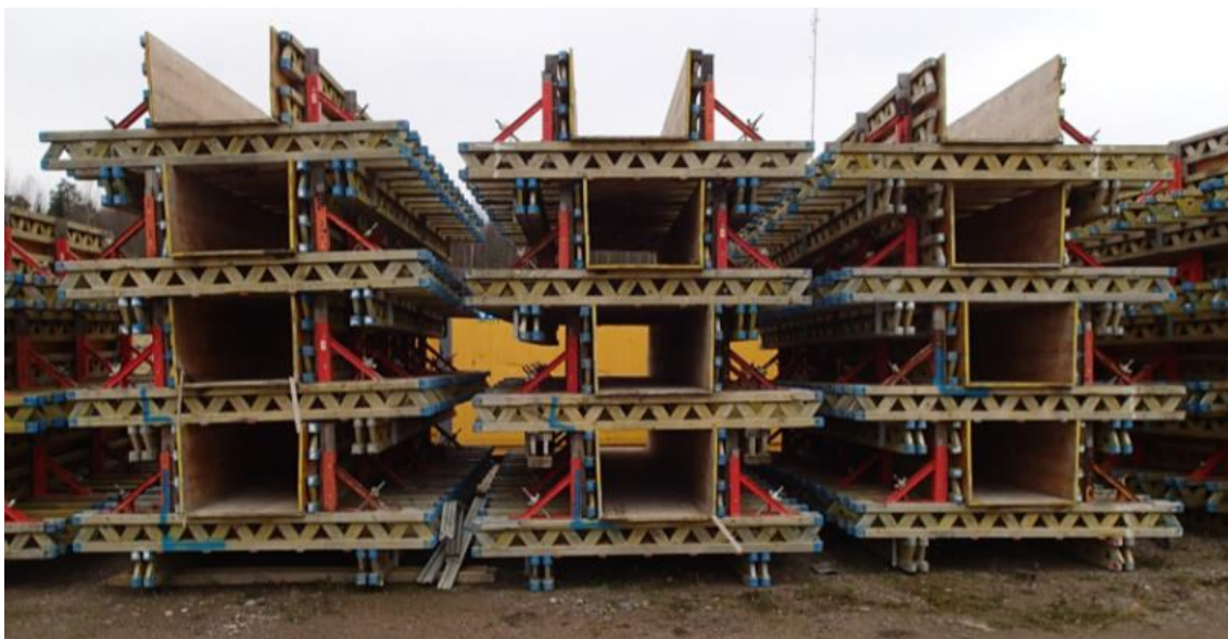
Kuva 9. Valmiit palkkimuotit varastoalueella.
