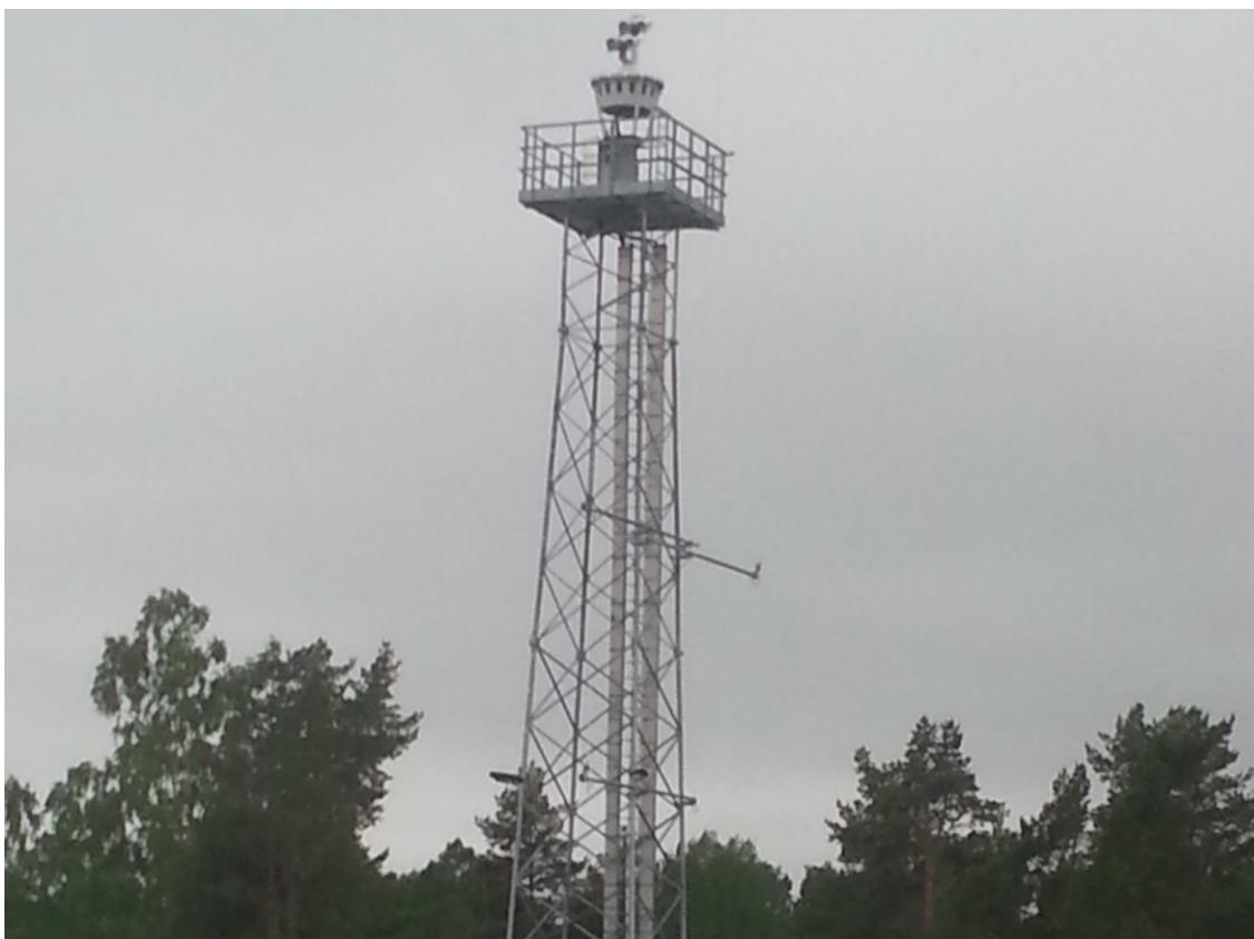
Kuva 15. Saabin kamerayksikkö maston huipulla Sundsvallin lentoasemalla (Alakoski).
