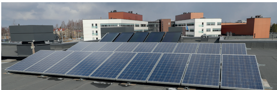
Kuva 2. Laboratorion katolla sijaitsevat aurinkopaneelit ja aurinkokennot (kuva Jorma Tuomisto).
