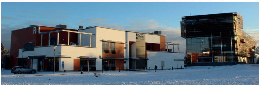
Kuva 1. Seinäjoen ammattikorkeakoulun rakennustekniikan laboratorio (kuva Terhi Kallio).
