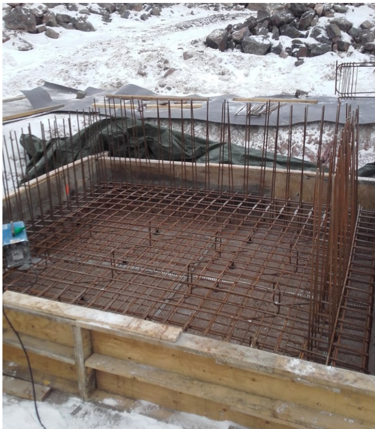
Kuva 9. Hissikuilun perustuksen suojaus ja sulana pito, sekä lämmitys.
