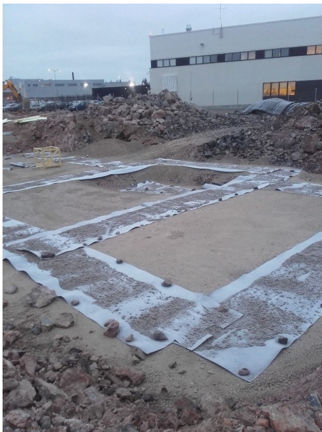
Kuva 11. Kaivutöiden jäljiltä nauha-anturoiden pohjat eristetty pakkasmatoin tammikuussa 2017.
