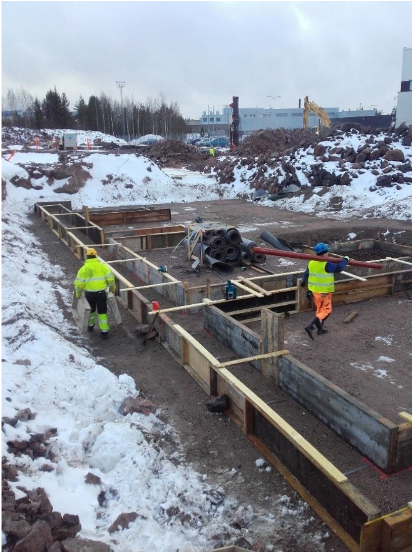
Kuva 12. Muottityöt käynnissä nauha-anturoilla tammikuussa 2017.
