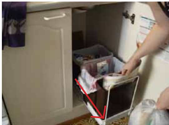
37. Jäteastiat ovat metallikehikossa, josta ne vedetään esiin tarvittaessa. Kehikko kolisee ja jäteastiat eivät pysy kehikossa pystyssä. Taaimmainen astia ei pysy pystyssä, joka aiheuttaa lisää siivottavaa.
