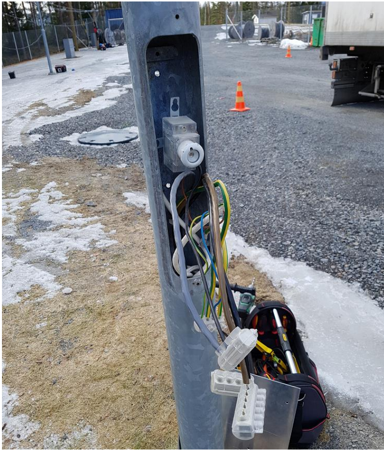
KUVA 44. Valaisinpylväs, johon latauspiste kiinnitetään (Kuva: Henri Hirvonen 2017)
