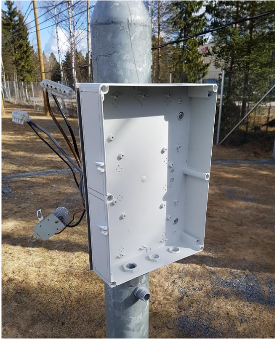
KUVA 45. Kotelon kiinnittäminen valaisinpylvääseen (Kuva: Henri Hirvonen 2017)
