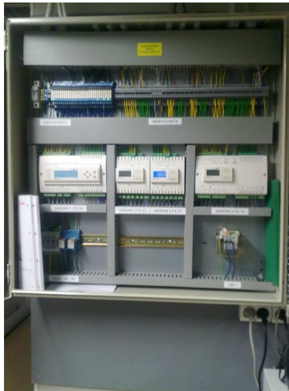
Kuva 4: Kuvassa on erään kohteen valvomoalakeskus. Säätimet ovat keskellä vasemmalta alkaen FX16, FX7, FX7 sekä FX14.
