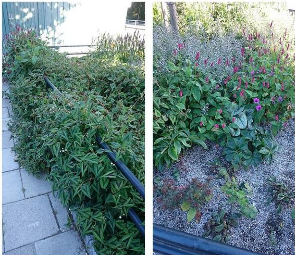
Kuva 18. Hulevesien imeytysrakenne Pilgatanilla. Sepelipinta on jäänyt osittain näkyviin perennojen väleistä. (Myllylä 2017)
