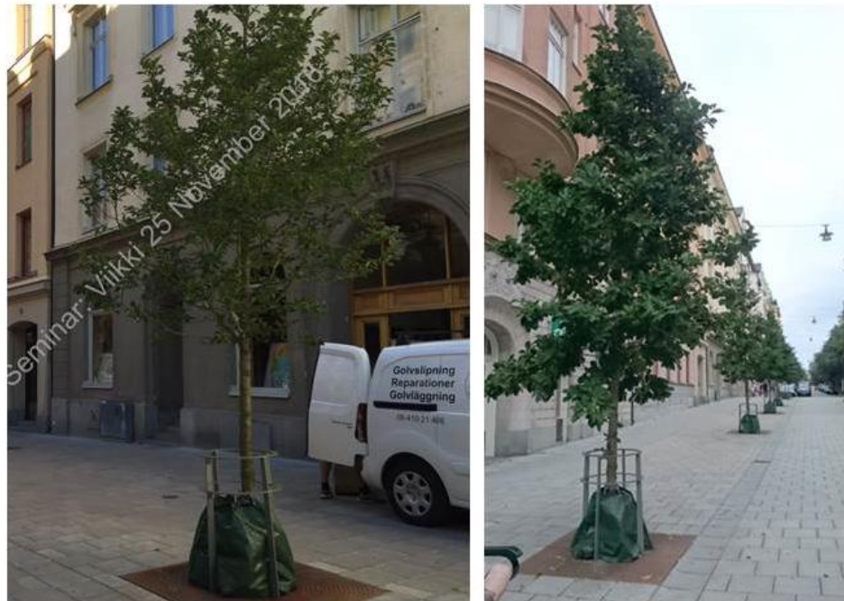
Kuva 11. Valmis rakenne vasemmalta oikealle vuonna 2016 ja 2017 (kuva vas: Embrén 2016b, 35; kuva oik: Hanna Myllylä 2017.)
