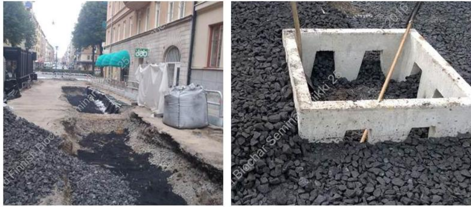
Kuva 10. Nybrogatan Tukholmassa rakennettiin vuonna 2015. Kuvassa istutuskaivanto ja oikealla betonilaatikko, jonka sisään uusi puu istutettiin. (Embrén 2016b, 31, 33.)
