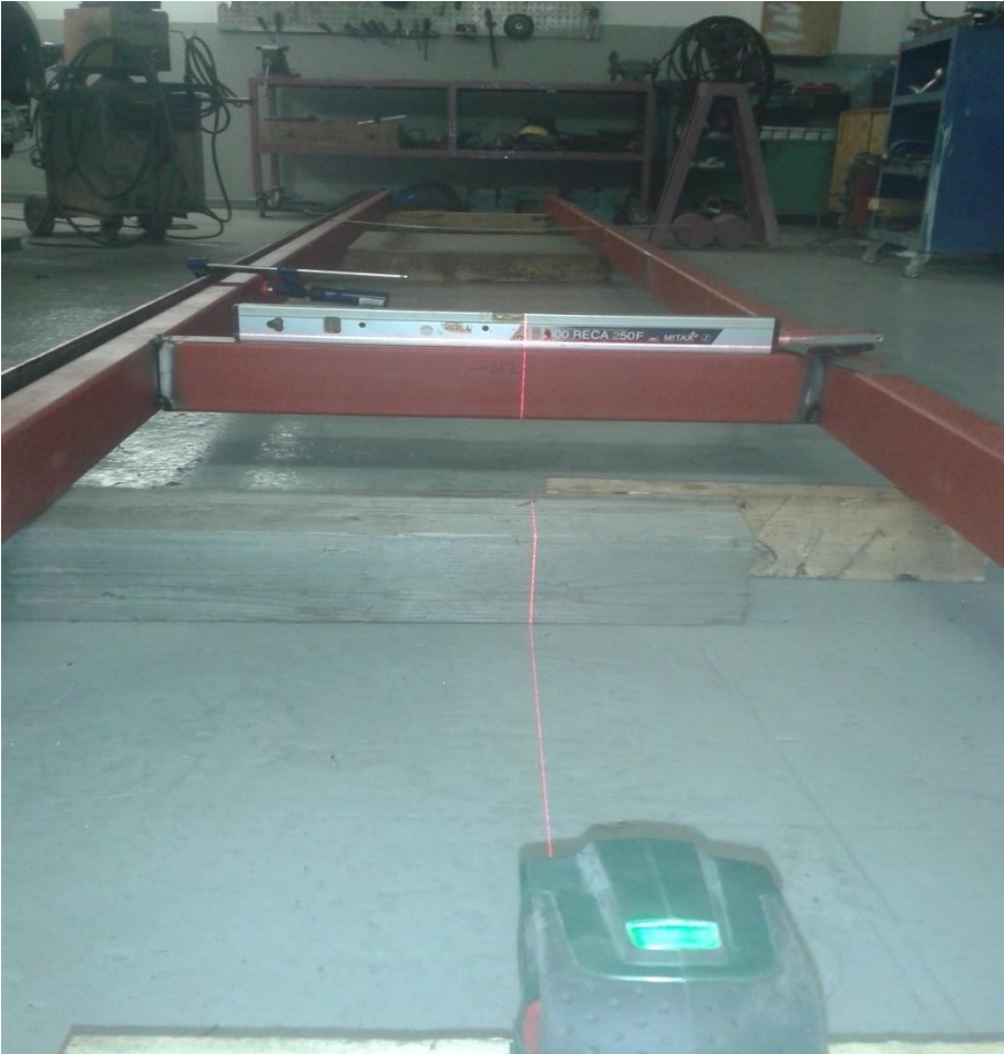
KUVA 4. Runkopalkkien suoraan laittaminen laserin ja vatupassin avulla.
