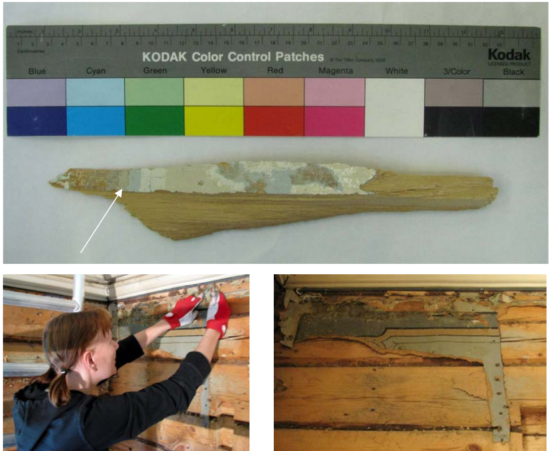
Kuvat 29 30 ja 31. Yläkuvassa kattopaneloinnin värikerrostumista tehdyt väriportaatt. Muutoskauden harmaa sävy merkitty kuvaan nuolella. Alhaalla vasemmalla tapettikerrosten irrottamista ensimmäisen muutoskauden seinämaalauksen päältä, oikealla esiinotettu fragmentti. (Kuva 29. Lehtinen 2010; Kuva 30. Pitkäniemi 2009; Kuva 31. Lehtinen, 2009.)
