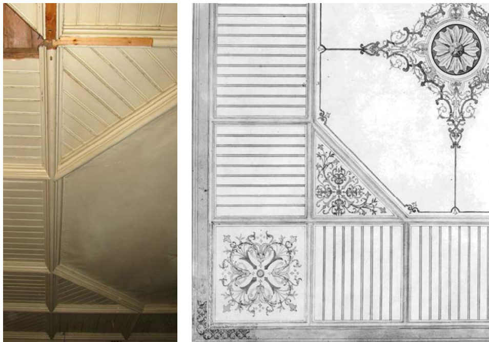
Kuvat 24 ja 25. Vasemmalla toteutunut kattopanelointi, oikealla alkuperäinen suunnitelmapiiustus. (Kuva 24. Lehtinen 2009; Kuva 25. Suomen rakennustaiteen museo).
