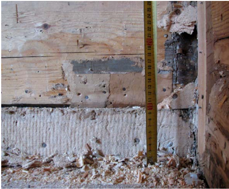
Kuvat 8 ja 9. Yläkuvassa keisarin salongin kattolistat ja alakuvassa keisarin salongin seinän alaosan pahvipaneloinnin fragmentteja (Kuva 8. Lehtinen 2010; Kuva 9. Pitkäniemi 2009).
