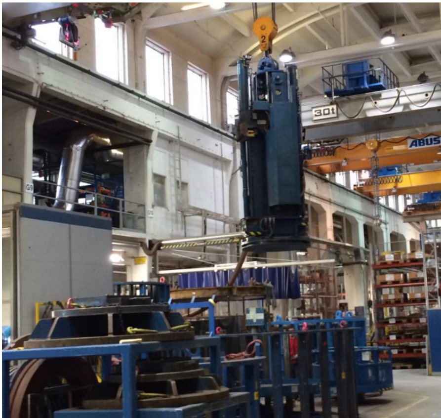
Kuva 17. Siirrettävä puristin, jota nostetaan ladotun levypaketin sisäpuolelle siltanosturilla.
