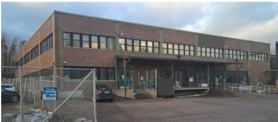
Kuva 31. Julkisivu Espoossa, sijaitsevasta kiinteistöstä
