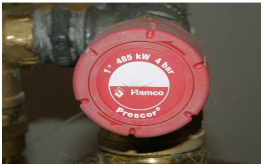
Kuva 22. Varoventtiili asennettuna [6].
