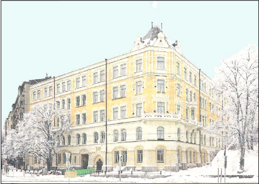
Kuva 52. Entinen Merenkulkuhallituksen virastotalo. (HS 2010a.)
