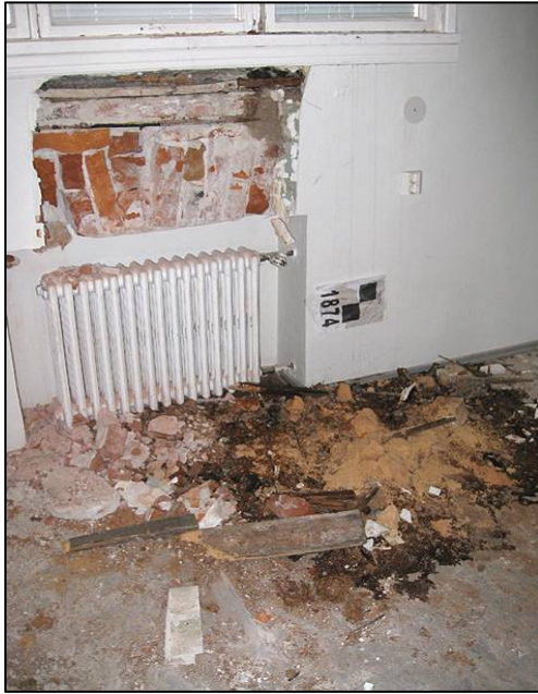
Kuva 10. Päärakennuksen rakenteita on avattu. (Lukkala 2010.)
