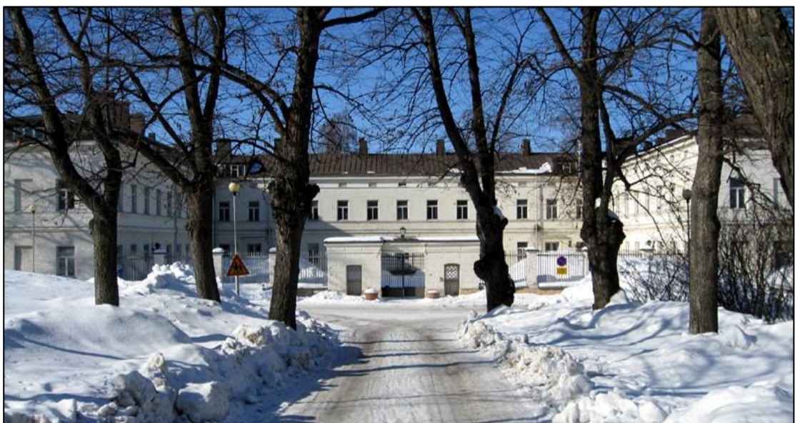
Kuva 6. Päärakennuksen sisäänkäynti. (Lukkala 2010.)
