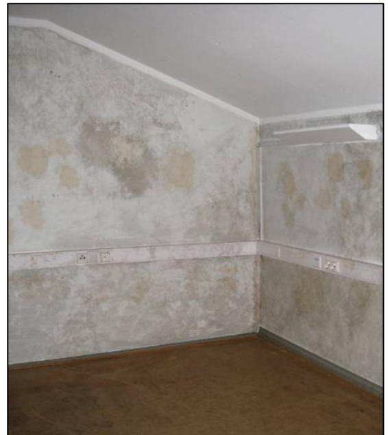
Kuva 13. Lavastemaalauk 3. kerros, C-alueen pohjoispääty. (Lukkala 2010.)
