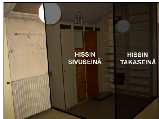
Kuva 29. Hissin sijainti entisen arkistohuoneen nurkassa. (Muokattu. Lukkala 2010.)
