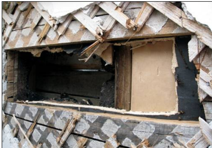
Kuva 16. Päärakennuksen 3. kerroksen tikkurapatu katto. (Lukkala 2010.)
