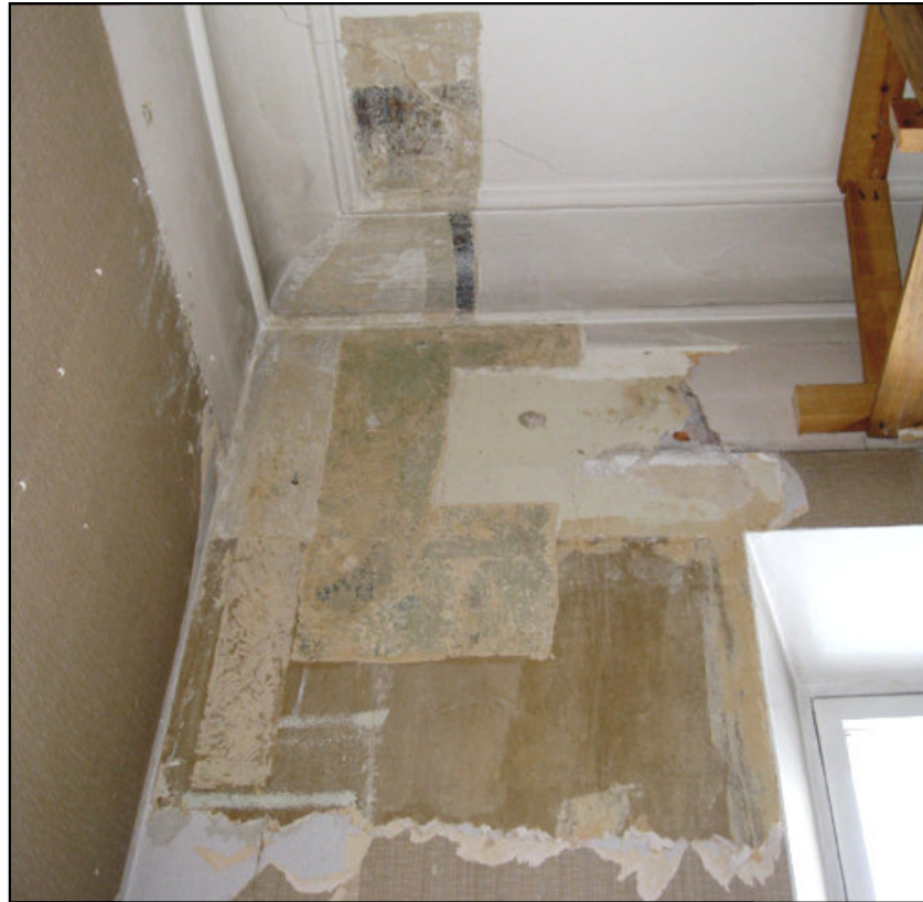
Kuva 54. Päärakennuksen C-alueen toisen kerroksen väritutkimuksia seinäpinnasta ja alakaton takaa löytyneistä kattopinnoista. (Lukkala 2010.)
