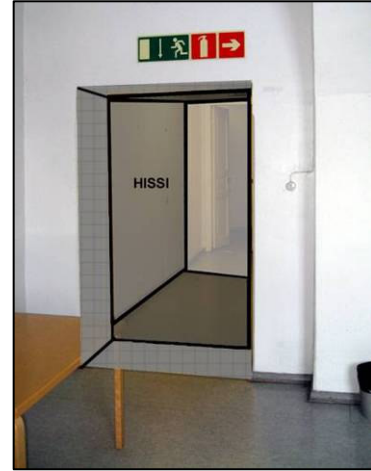
Kuva 31. Itäisen aulatilan seinä joudutaan sulkemaan hissien B tieltä. (Muokattu. Lukkala 2010.)
