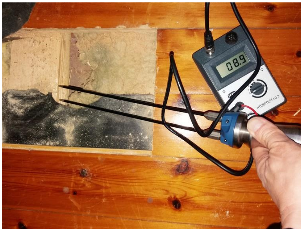
Kuva 10. Rakenneavaus ja kosteusmittaus. Suomenlinna B 42. Kuvaaja Pekka Vuorela. 2017.
