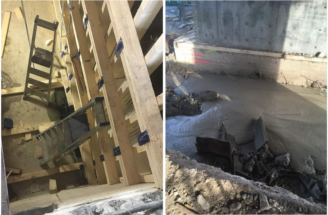
Kuva 28. Vasemmalla räjähtänyt muotti josta massat valunut alakertaan ja oikealla kuva alakerrasta mihin massat kerääntyi.
