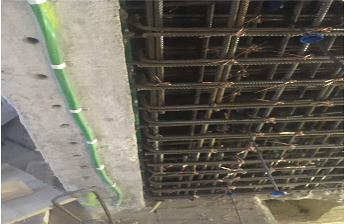
Kuva 17. Injektointiletku asennettu paikalleen.
