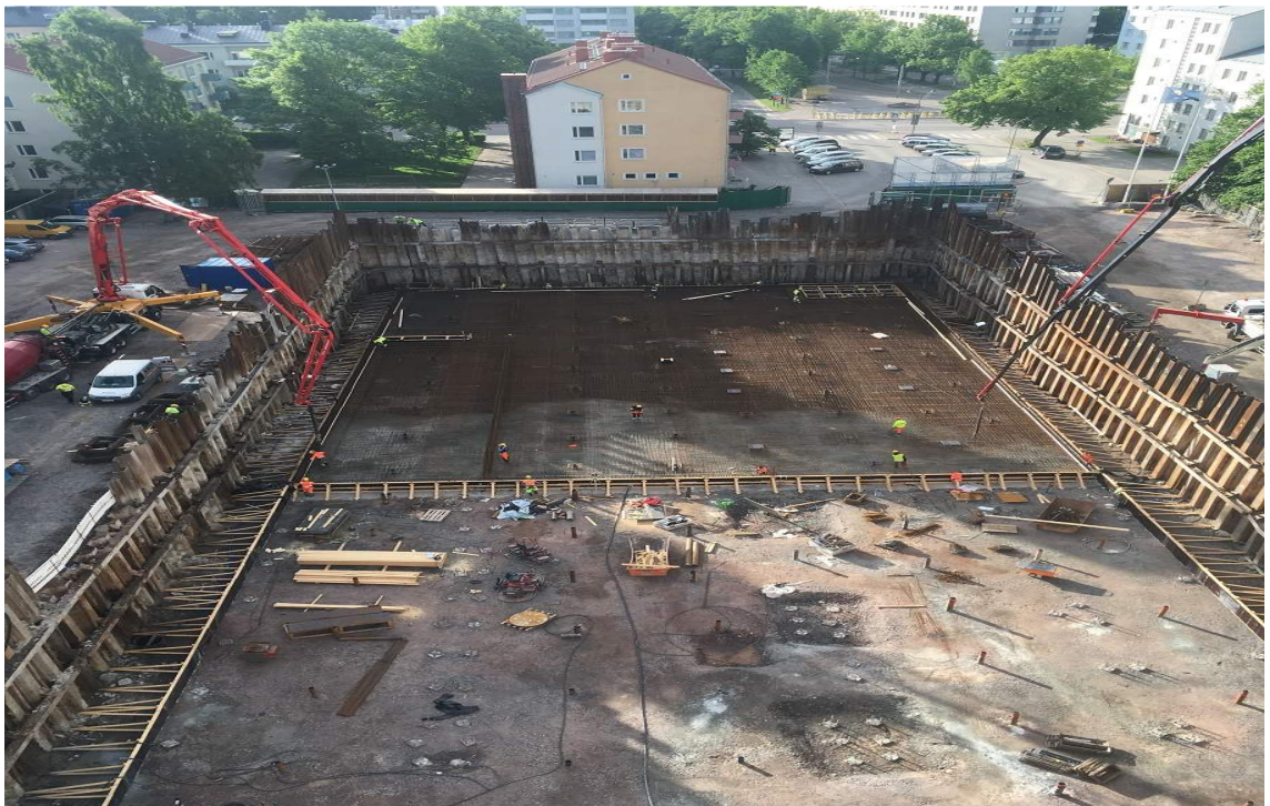
Kuva 32. Town House paalulaattavalu 840 m 3 (32m*40m*0,66m). Kuvanotto hetkellä valua takana 1,5h.
