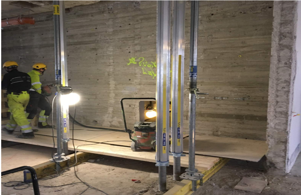
Kuva 16. Hiltin imuterä TE-YD käytössä kun porataan tartuntoja vahvistettavaan seinään.
