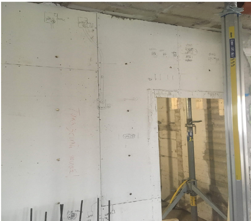
Kuva 19. Mittamies on merkannut muottiin reikäkuvan mukaiset varaukset kirvesmiehelle.
