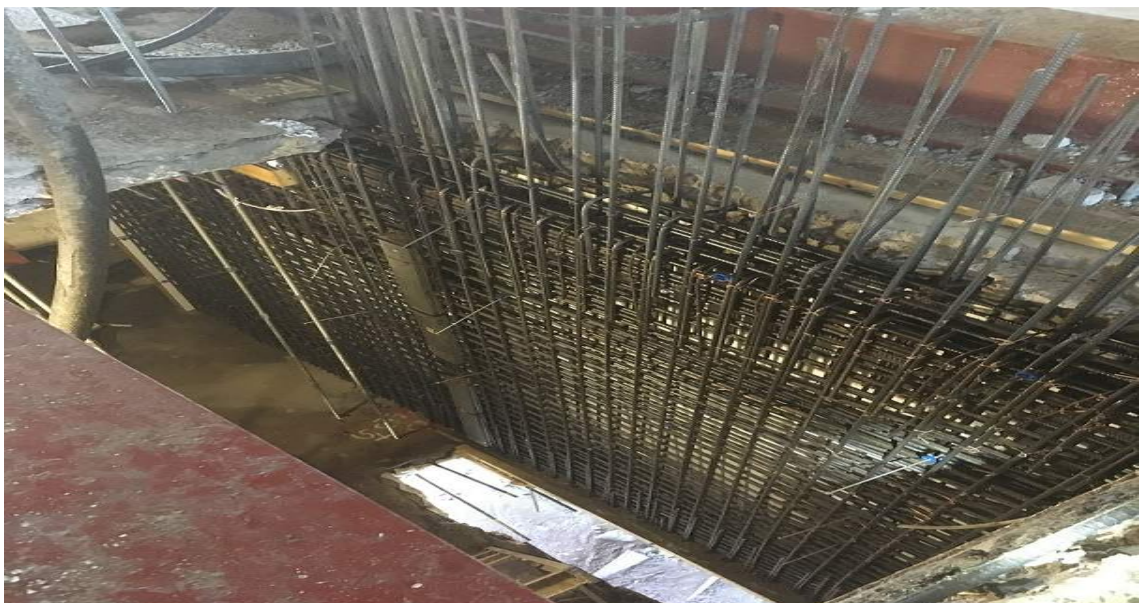
Kuva 29. Muotti purettu ja putsattu painepesurilla.
