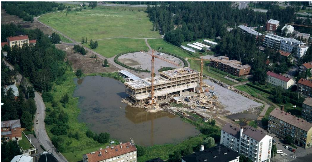
Kuva 1. 1972 otettu kuva Kone Oy:n uuden konttorin rungon paikallavalun aikana [1.]
