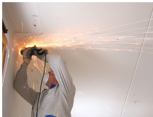
Kuva 20. Lentävät kipinät saattavat aiheuttaa tulipalon
