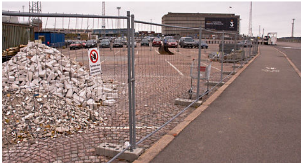
Kuva 1. Työmaa-alueen erottaminen ympäristöstä aitaamalla
