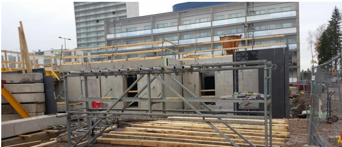
Kuva 2. Kampafakki tasaisella alustalla niittysillankulman työmaalla.
