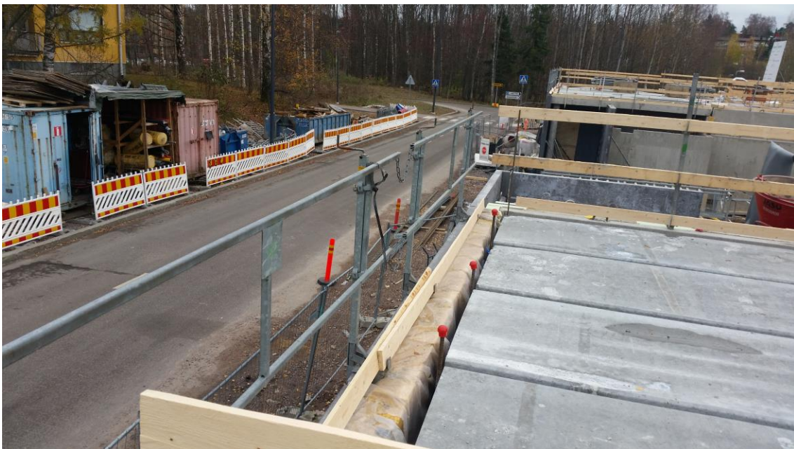
Kuva 5. Niittysillankulma 1 työmaalta, jossa ensimmäiset ontelot ja kaiteet on asennettu.
