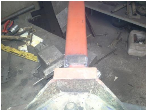
Kuva 48 Uusi putki hitsattuna
