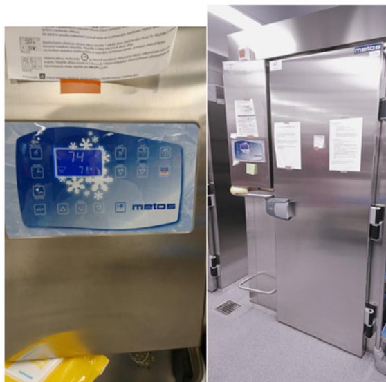
KUVA 2. Jäähdytyskaappi ja lämpötilamittarin näyttö mittauksen alkaessa
