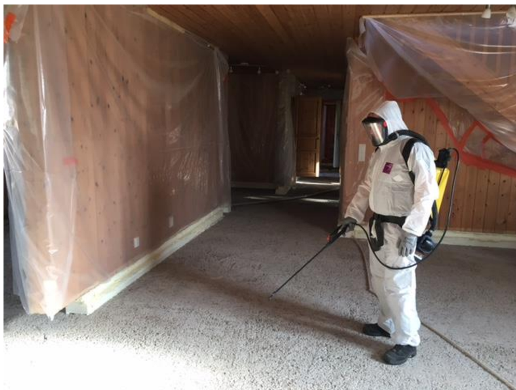
KUVA 6. Desinfointi odoxilla ennen kuivausasennusta (Sainio 2017-08-11.)
