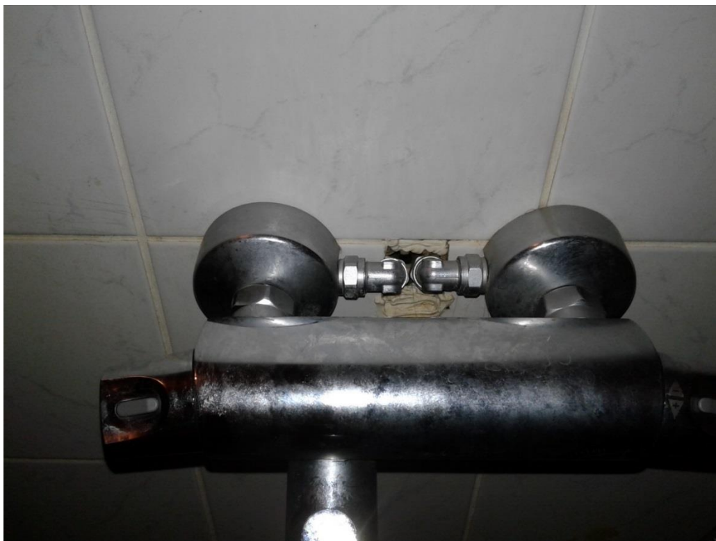
KUVA 17. Suora yhteys hormiin (Sainio 2017-06-14)
