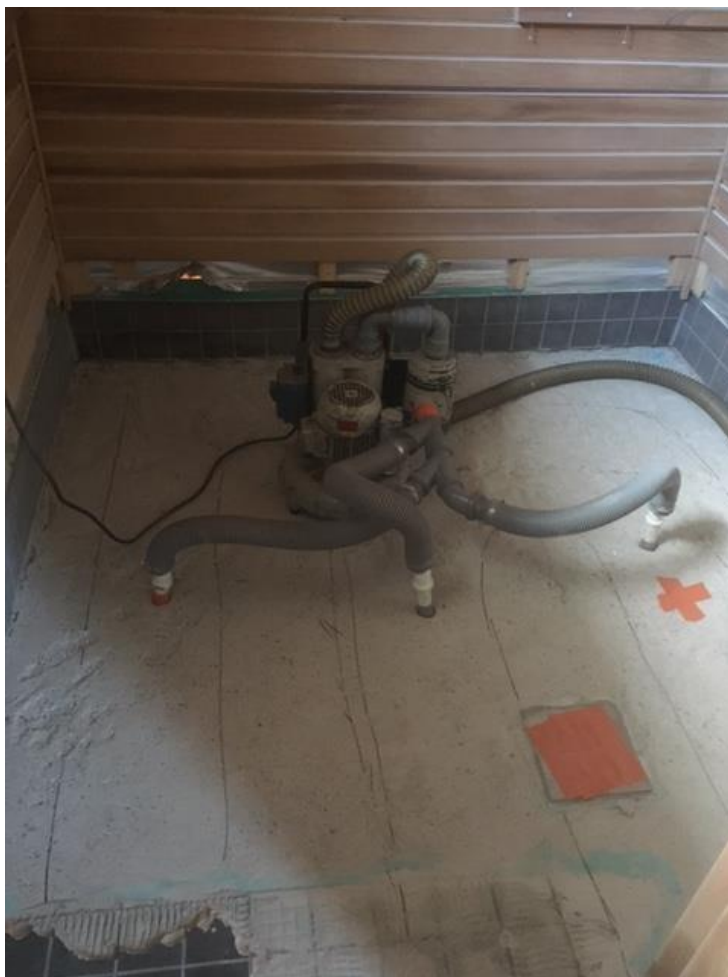
KUVA 9. Imukuivaus saunan lattialla (Sainio 2017-08-14.)
