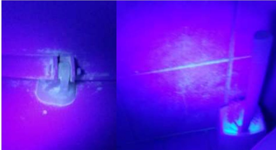
KUVA 9. UV-valoa käytettiin apuna tarkastuksilla
