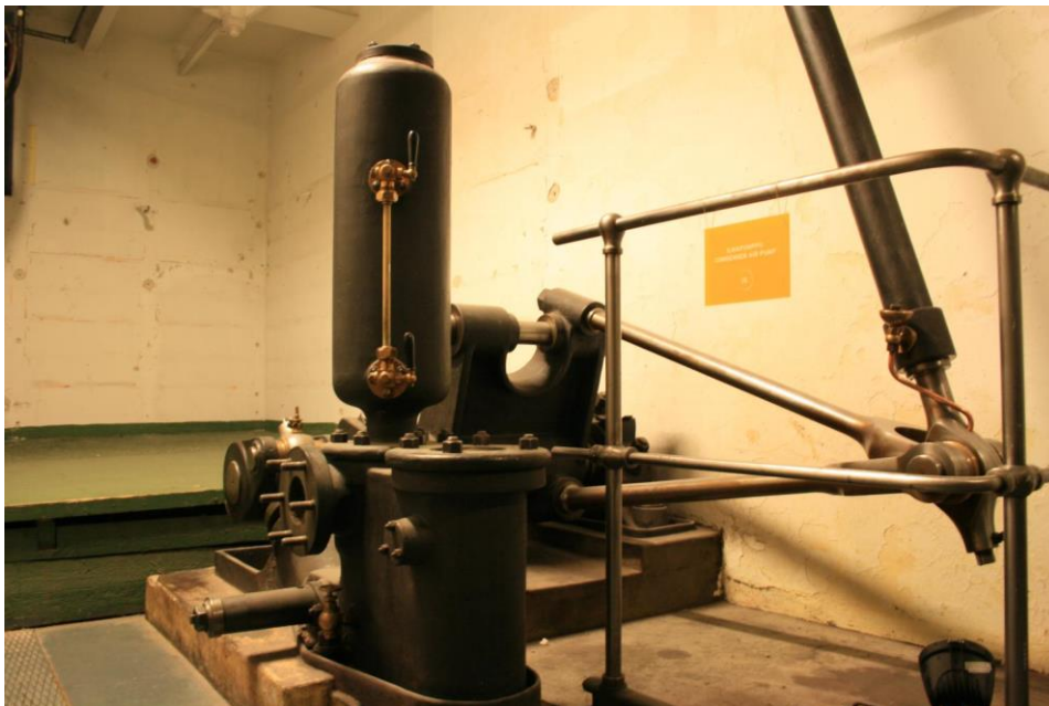
KUVA 5. Alakerroksen pumppu, joka on osittain purettu. Oikealla koneeseen liitetty, pumppua käyttävä akseli. (Kuva: Roope Viita 2017)
