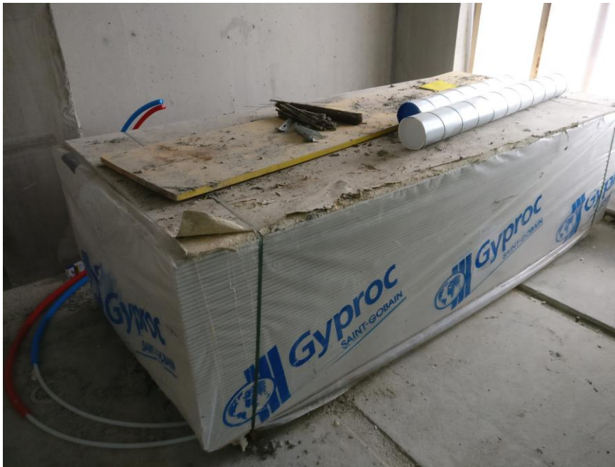
KUVA 6. Kipsilevynippu varastoituna esimerkkityömaalla.
