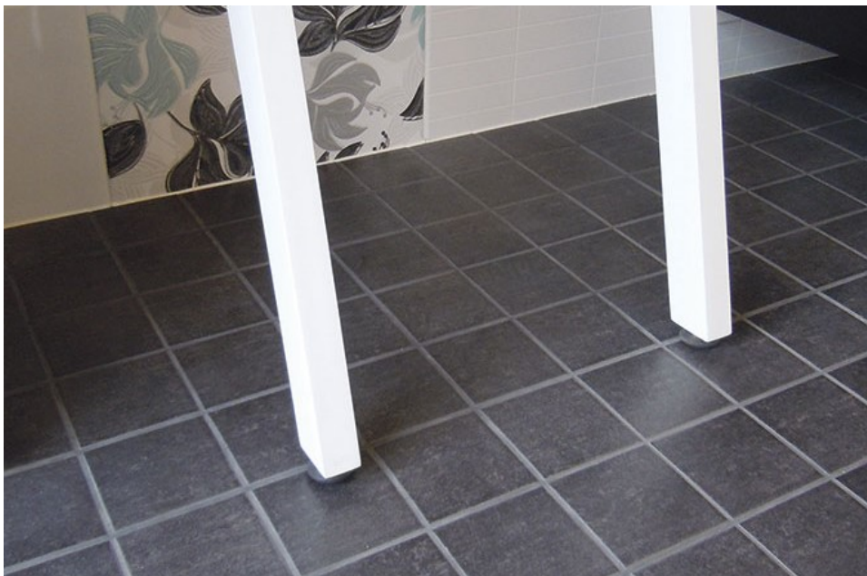
Kuva 10. Lattialaatoitus. (RTV oy 2017, kokoelmat)
