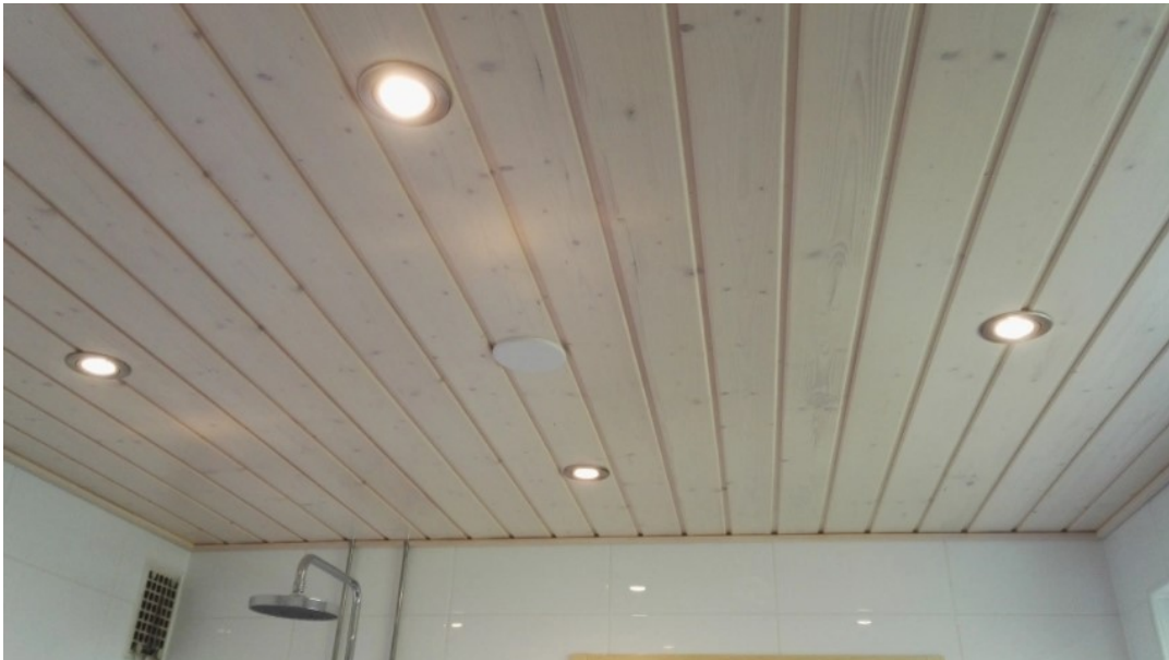
Kuva 13. Puupaneelikatto. (Pohjavirta Oy Rakennuspalvelut 2017)
