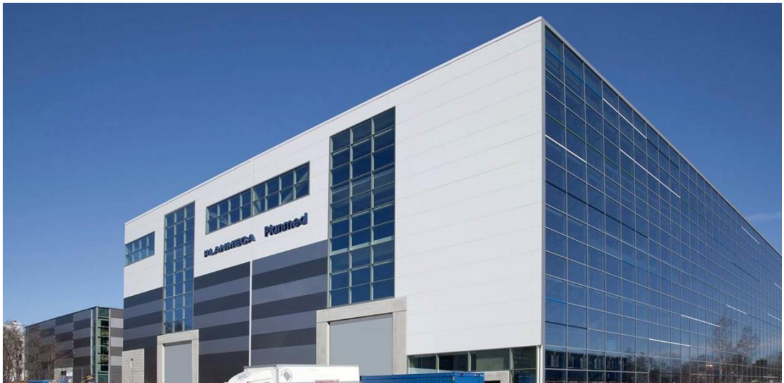
Kuva 4. E-talo. KoMa sijaitsee 1. kerroksessa ja vastaanottotarkastus 3. kerroksessa [7].
