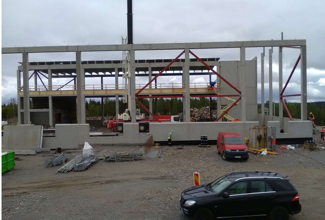
KUVA 4. tt-laattojen asennusta. (Hotokka 2017)
