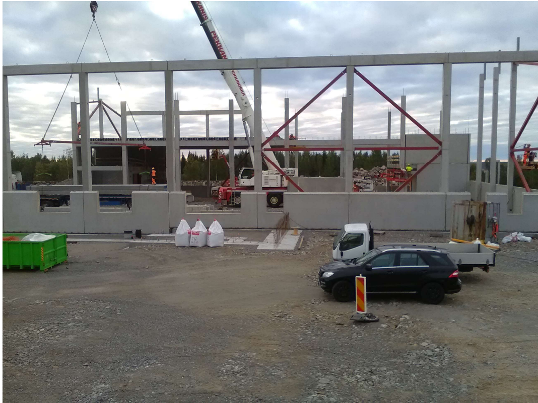
KUVA 3. Teräsjäykisteet asennettuna. (Hotokka 2017)
