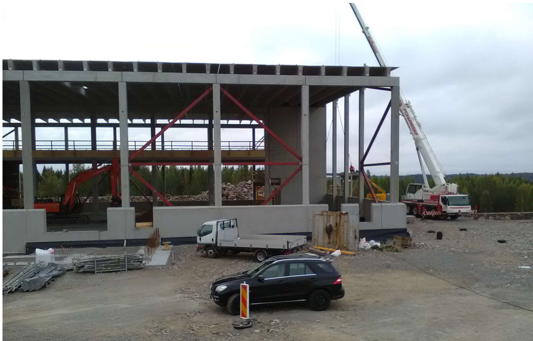
KUVA 5. Kaikki ontelot asennettuna (Hotokka 2017)
