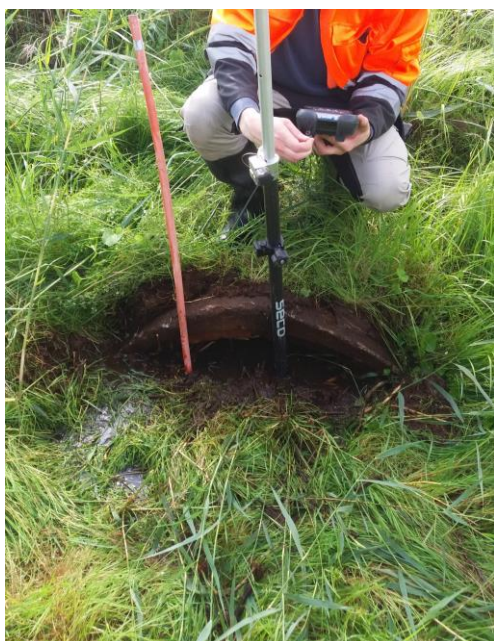
Figurer 7-8. Exempel på tvärgående trumma under en väg som monterats för lågt. Trumman är 1 meter i diameter.
