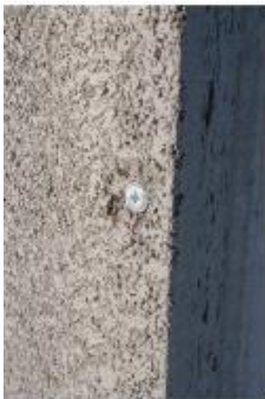
KUVA 8. Nurkkaliitoksen varmistus (Rakennusbetoni 2014)
