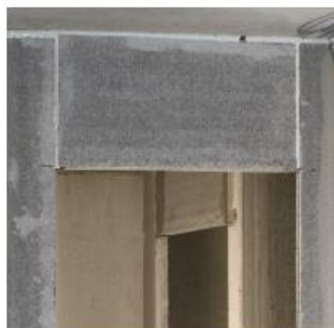
KUVA 9. Ovenylityspala (Rakennusbetoni 2014)
