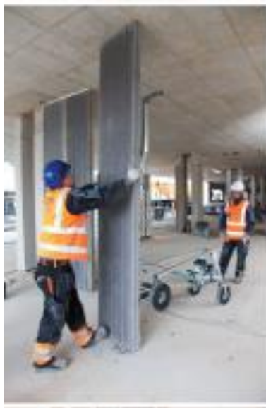
KUVA 7. Elementtien asennusta (Rakennusbetoni 2014)
