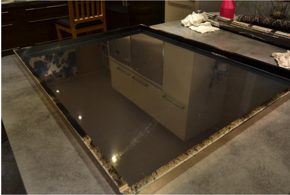
Kuva 13. Kehykset asennettuna pinnoitetun lasin päälle [34].
