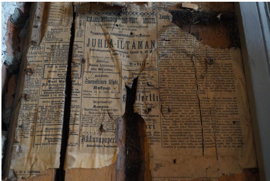
Kuva 13. Seinään liisteröity sanomalehti (Vattulainen 2017)
