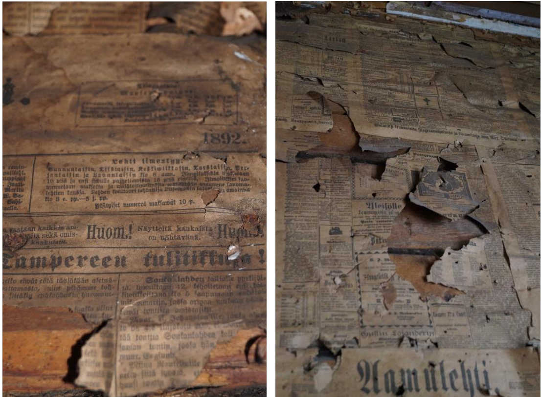
Kuvat 18 ja 19. Tummunutta paperia ja reikiä sanomalehdessä (Vattulainen 2017)
