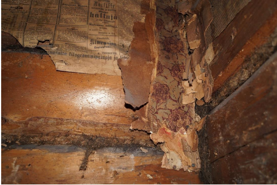
Kuva 14. Sanomalehden päällä olevaa tapettikerrostumaa (Vattulainen 2017)
