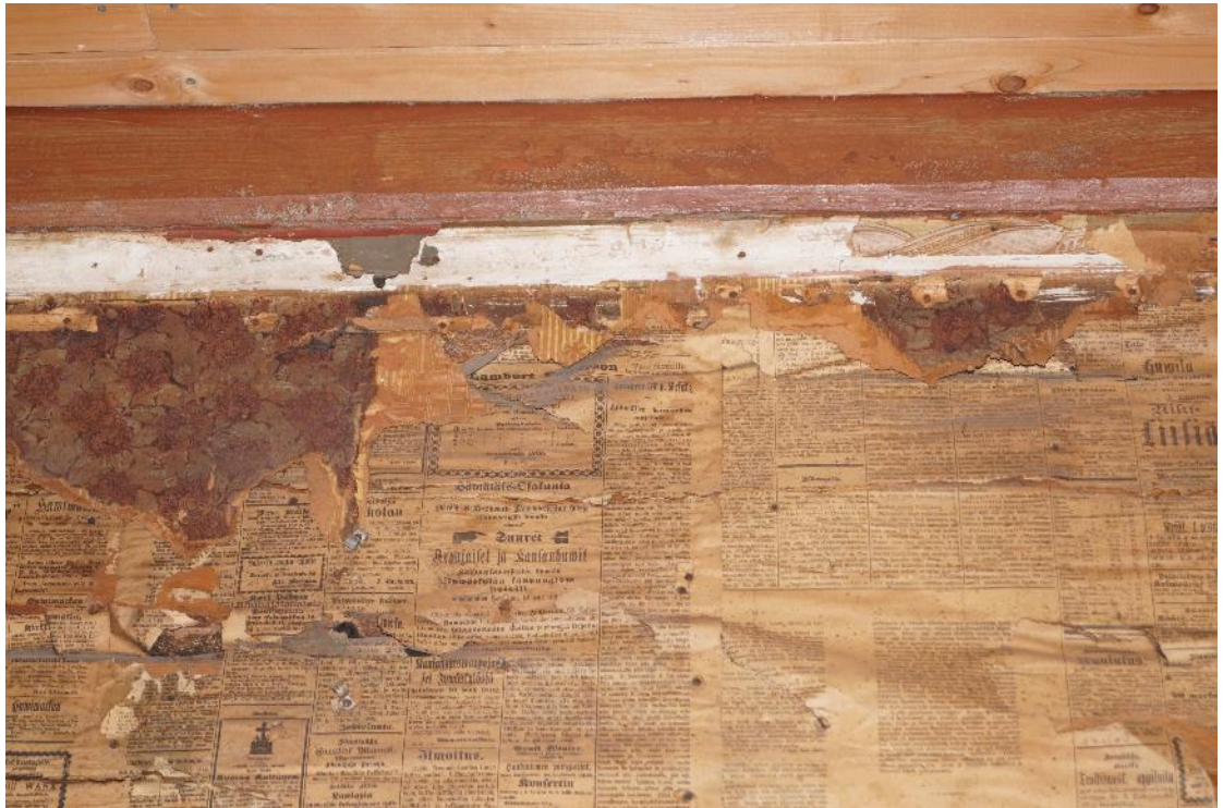
Tapettia sanomalehden päällä, länsiseinä (Vattulainen 2017)
