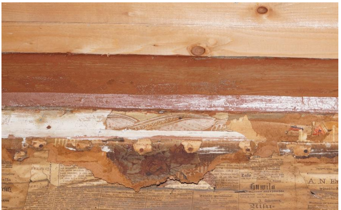
Tapettia sanomalehden ja listan päällä, länsiseinä (Vattulainen 2017)
