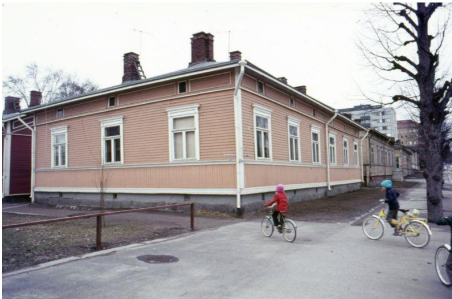
Kuva 9. Vaaleanpunainen talo tontilla 43, jossa sanomalehti sijaitsee. Kuvannut Arne Mänistö 25.04.1975. (Siiri-kuvapalvelu 2017)
